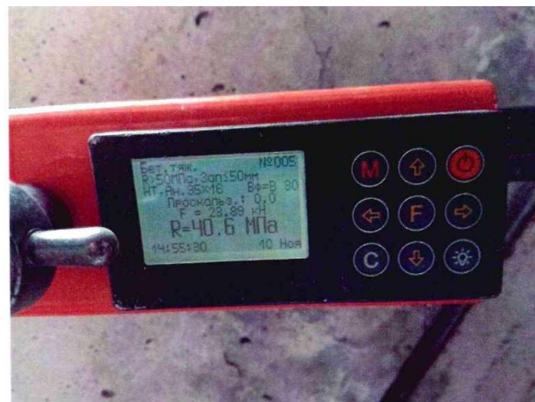
Рис. 5. Определение прочности бетона методом отрыва со скалыванием прибором ОНИКС-1.0С
