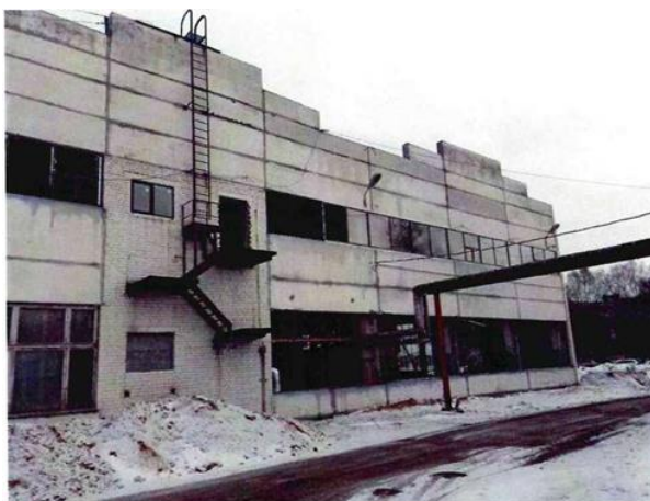
Рис. 2. Фрагмент фасада здания в осях Ж-А
