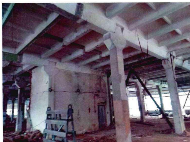
Рис. 3. Каркас здания в осях 1–8
