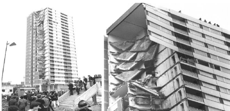
Рис. 1. Последствия прогрессирующего обрушения
