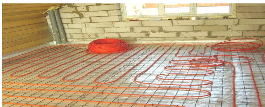
Рис. 2. Устройство электрического пола
