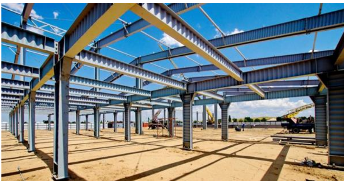
Рис. 2. Одноэтажный цех в металлическом каркасе, выполненный с использованием балок с гофрированной стенкой [6]
