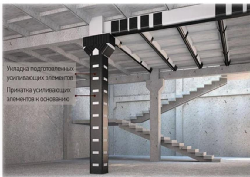
Пример усиления конструкций углеволокном
