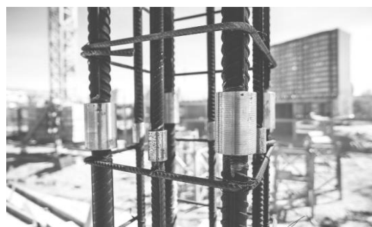
Рис. 3. Резьбовые муфты в составе каркаса
