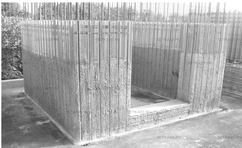
Рис. 2. Монолитная стена из несъемной металлической опалубки
