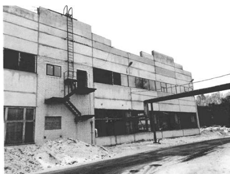
Рис. 2. Фрагмент фасада здания в осях Ж-А
