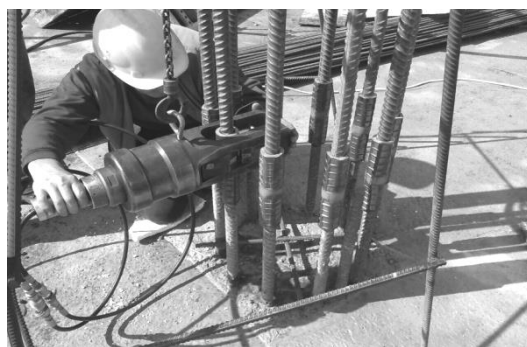
Рис. 1. Выполнение обжима муфты гидравлическим прессом
