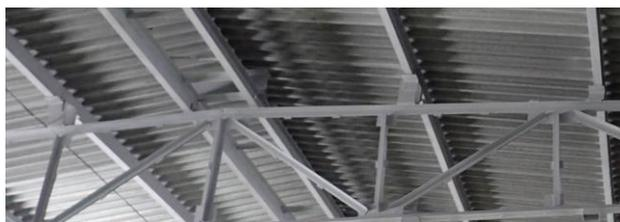
Рис. 4. Внеузловое опирание прогонов кровли (по осям 1–6)
