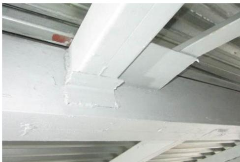
Рис. 2. Крепление прогонов к балкам перекрытия в осях Б–В
