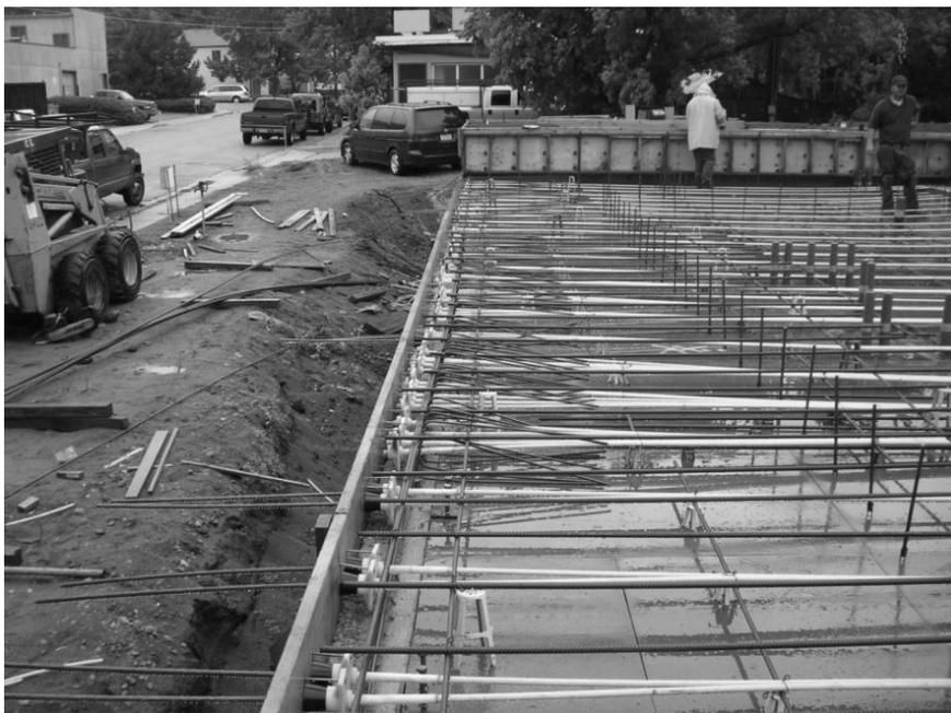
Рис. 1. Пример практического применения технологии постнапряжения без сцепления при возведении фундаментной плиты
